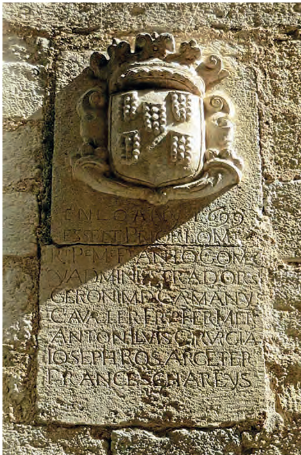
Escut que commemora a la façana de l'església del Carme la construcció de la capella de la Puríssima Sang (1699-1700). Arxi-confraria de la Puríssima Sang. Pedres de Girona. https://www.pedresdegirona.com/sang_0_tm
